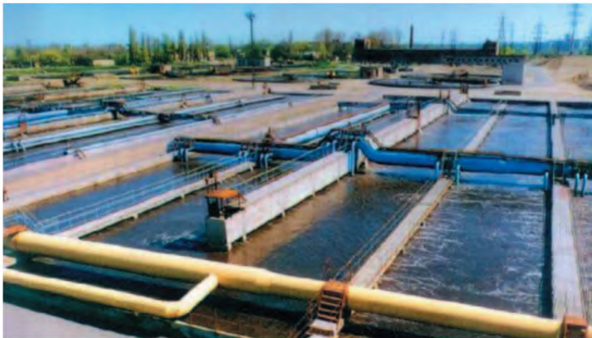
Фото 1. Очистные сооружения канализации города Ростова-на-Дону. Технологические нитки первой очереди
